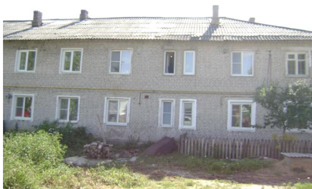
До капитального ремонта
