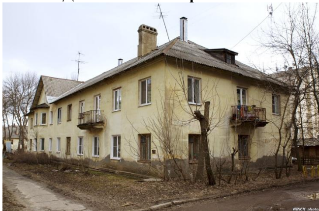
До капитального ремонта
