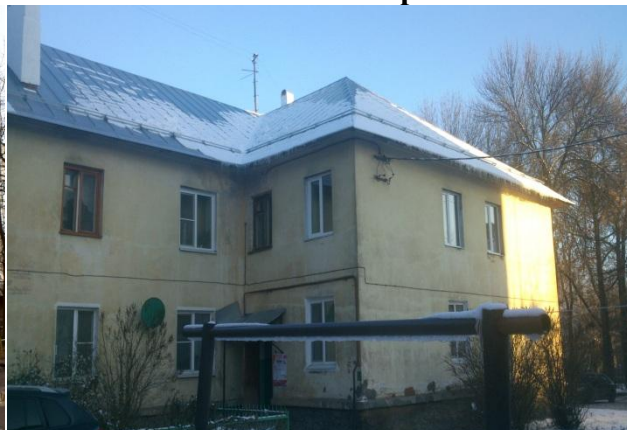
После капитального ремонта
