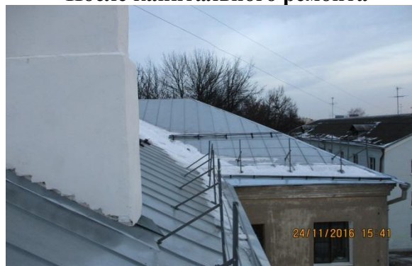
После капитального ремонта
