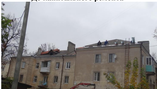
До капитального ремонта
