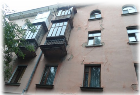
Фасад многоквартирного дома №2а по улице Большие Ременники в городе Владимир ДО капитального ремонта
