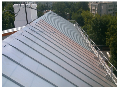
Кровля многоквартирного дома №23 по улице Никитская в городе Владимир ПОСЛЕ капитального ремонта
