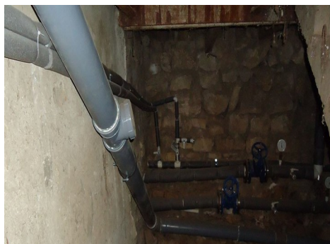
Внутридомовые инженерные системы многоквартирного дома №78 по улице Лопатина в городе Ковров ПОСЛЕ капитального ремонта
