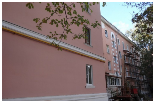
Фасад многоквартирного дома №2а по улице Большие Ременники в городе Владимир ПОСЛЕ капитального ремонта
