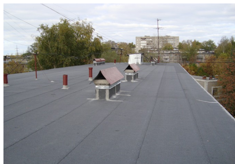
Кровля многоквартирного дома №155 по улице Лакина в городе Владимир ПОСЛЕ капитального ремонта
