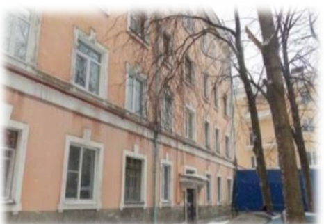
Фасад многоквартирного дома №3 по Ерофеевский спуск в городе Владимир ДО капитального ремонта
