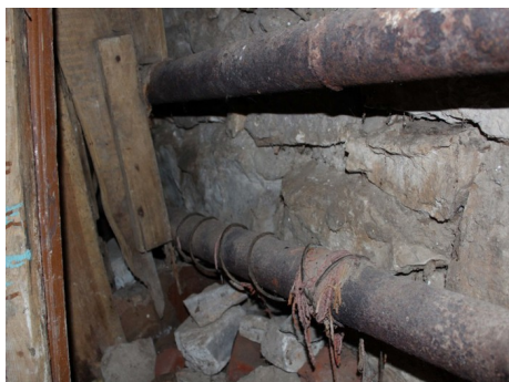
Внутридомовые инженерные системы многоквартирного дома №78 по улице Лопатина в городе Ковров ДО капитального ремонта
