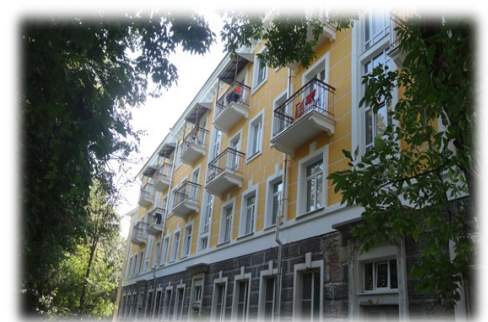
Фасад многоквартирного дома №3 по Ерофеевский спуск в городе Владимир ПОСЛЕ капитального ремонта
