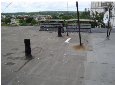
Кровля многоквартирного дома №155 по улице Лакина в городе Владимир ДО капитального ремонта
